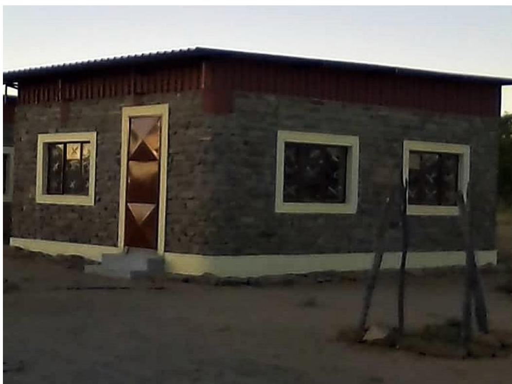
Das neue Klassenzimmer in der Entstehung
