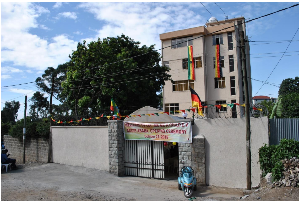
Der Neubau mit größeren Aufenthalts-, Unterrichts-, Werkstatt- und Büroräumen.
